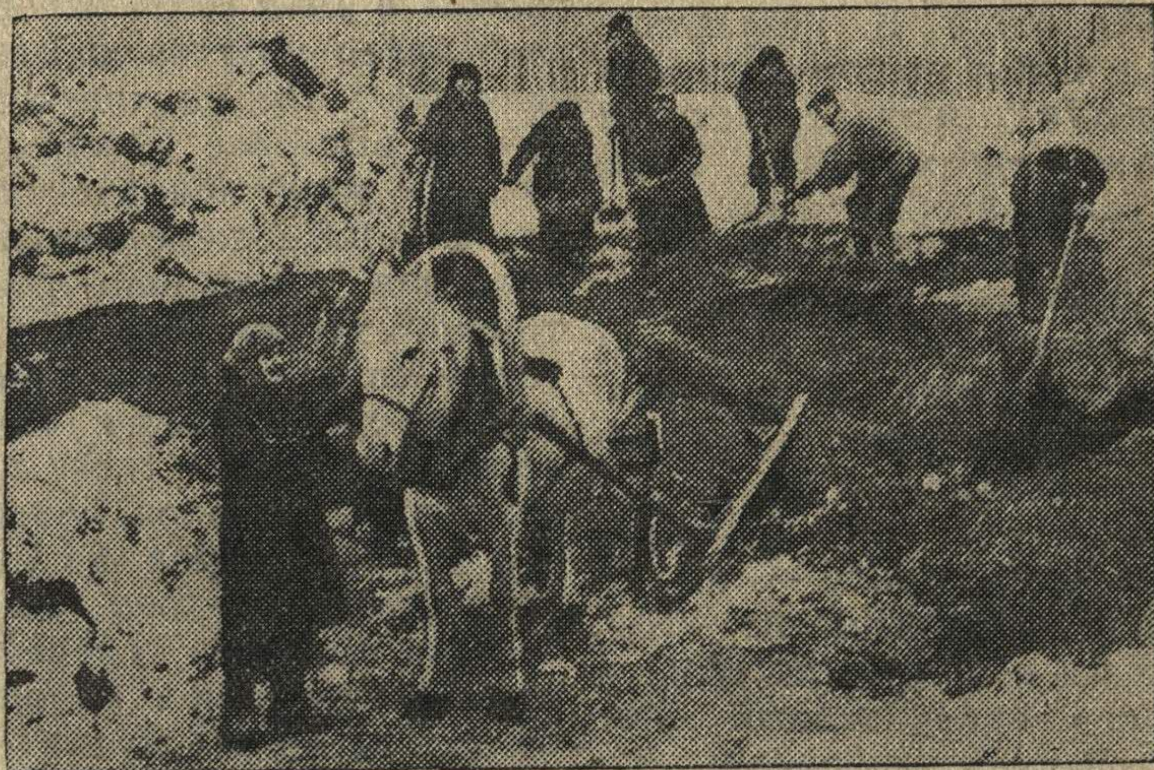
На строительстве народной магистрали Горький—Арзамас—Кулебаки. На снимке: раскрытие карьера и накладка песка на подводы молодежной бригадой, руководимой комсомолкой Марией Зотовой (Хватовский колхоз).
