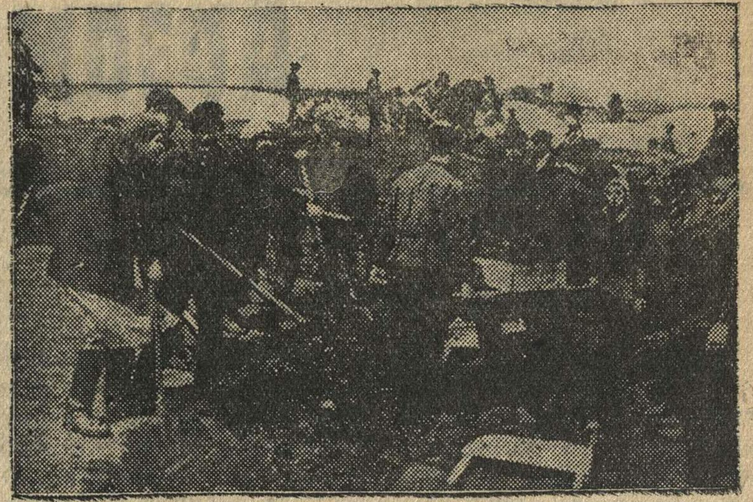
На снимке: Коллектив Арзамасского комтреста на трассе строительства народной магистрали в выходной день—18 мая.
