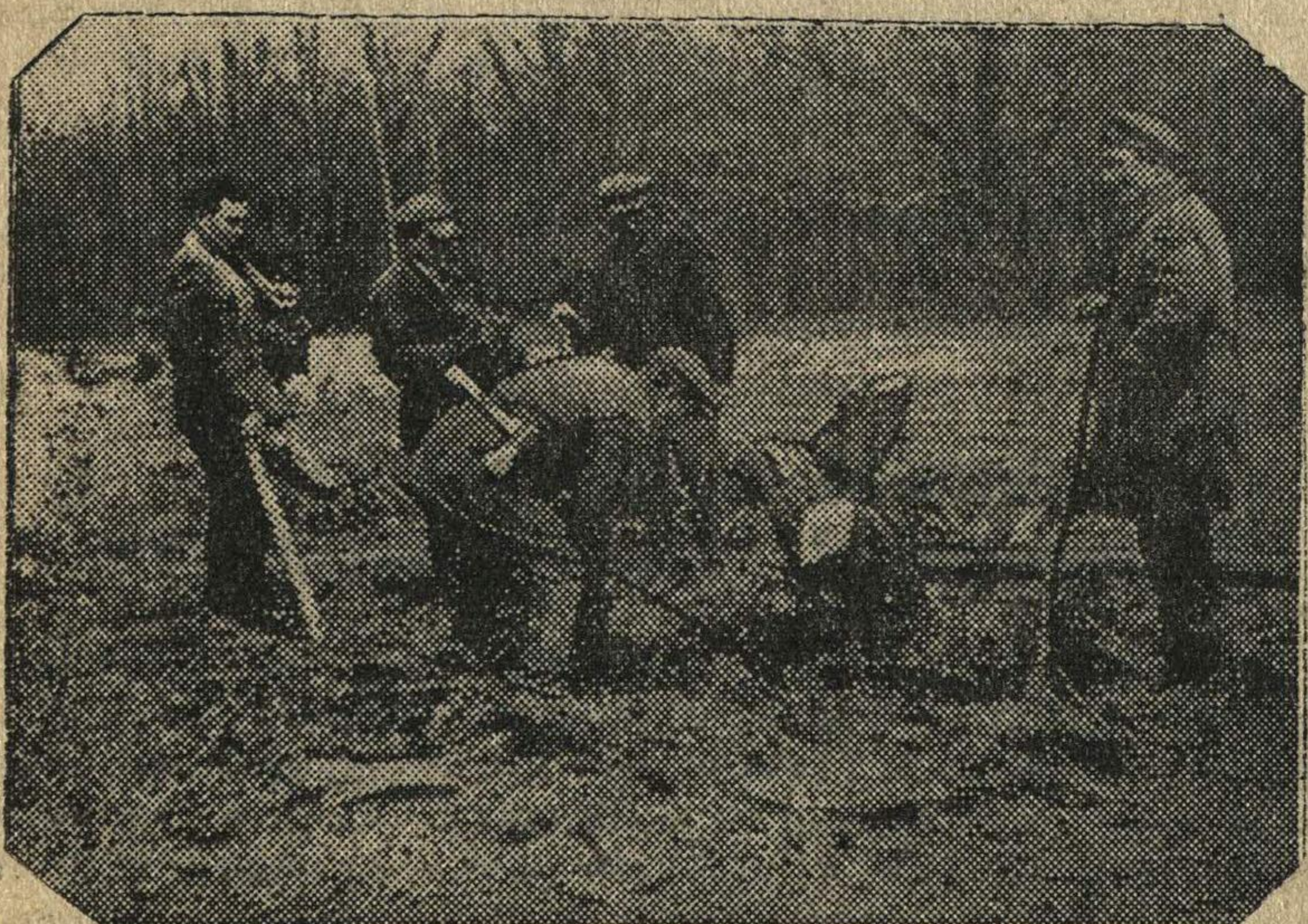
На первом прорабском участке строительства народной магистрали заканчивается корчевка пней. На снимке: закладка взрывчатых веществ под пеньки на участке Казаковского сельсовета. Фото Н. Евстигнеева.
