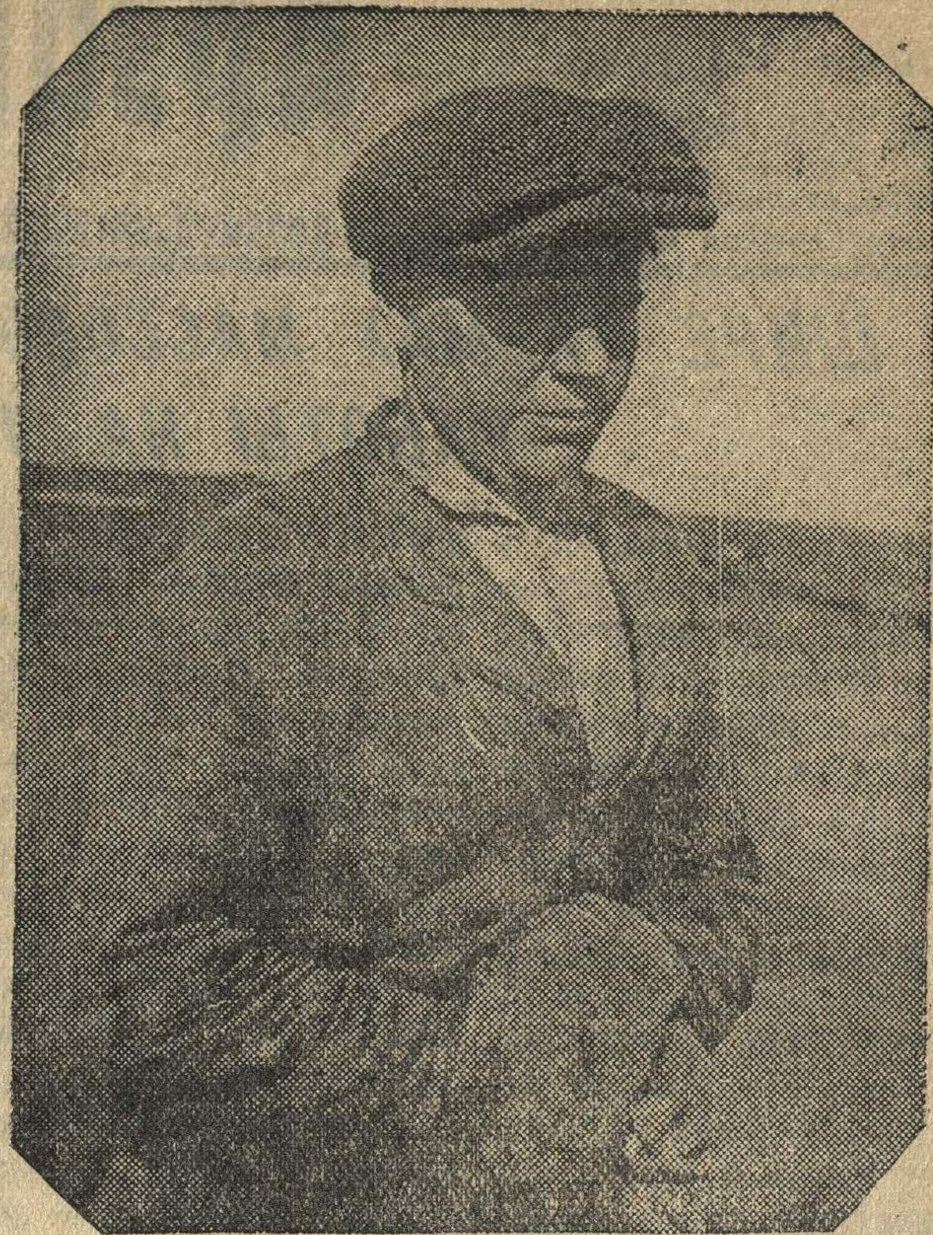
На снимке: А. И. Забородкин , стахановец Больше-Тумановского колхоза. На строительстве народной магистрали Горький—Арзамас—Кулебаки выполняет в день земляных работ в объеме 12—15 кубометров.
