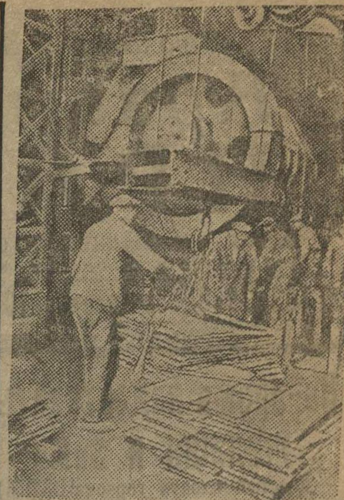
Среднесортный прокатный стан, восстановленный на Днепропетровском заводе имени Дзержинского, уже дает продукцию для возрождаемой промышленности Украины.
