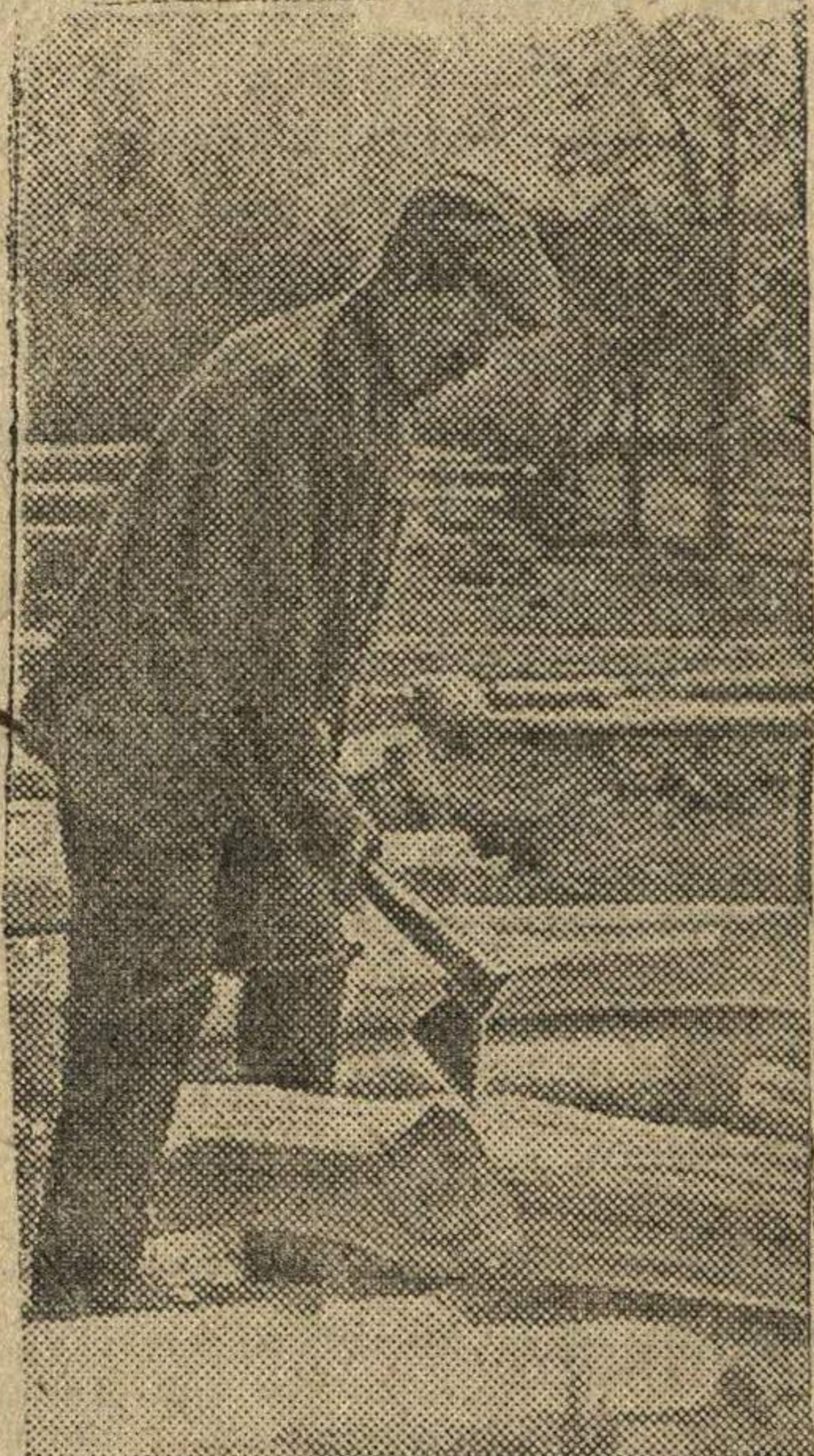
Отступая под ударами Красной Армии, фашисты выжгли сотни деревень Смоленской области. В освобожденных районах развернулось новое строительство. Колхозники дер. Редькино Я. Г. Захаров строят новую избу. Фото В. Арефьева. Фотохроника ТАСС.
