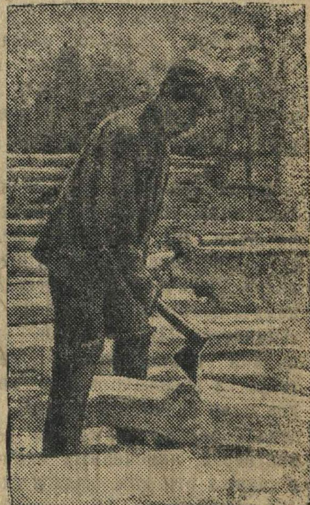
Колхозник дер. Редькино Я.Г. Захаров строит новую избу. Фото В. Арефьева.
