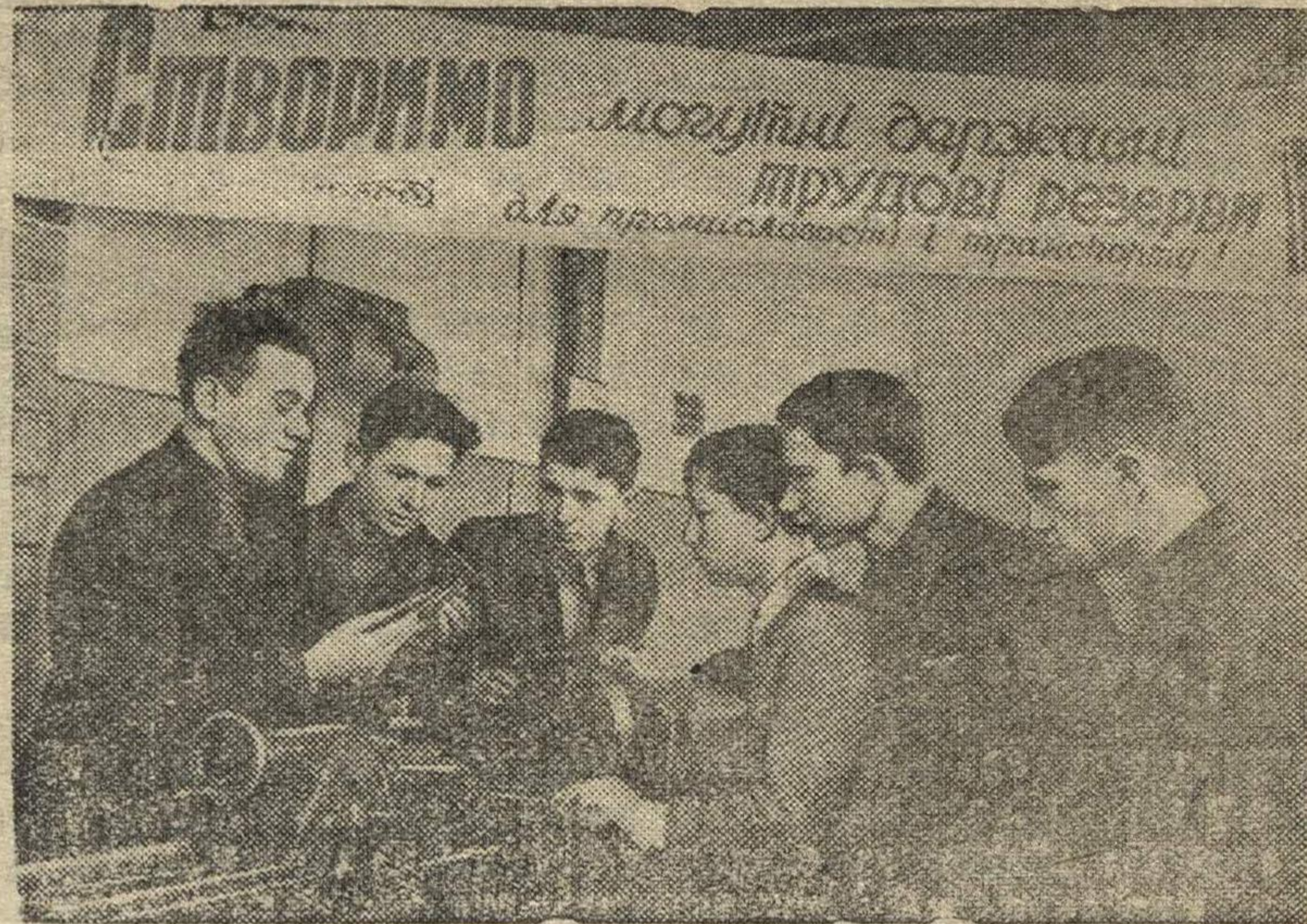
На снимке: Мастер фрезерного дела ремесленного училища № 8 в г. Киеве Б. М. Дробот объясняет ученикам назначение головки вертикального фрезерного станка.
